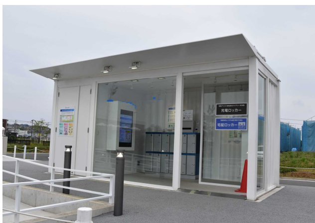
電動アシスト自転車バッテリー（蓄電池）充電ロッカー
