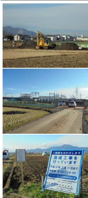
Bブロックの工事状況
